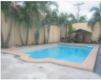
Swimming Pool : プール
